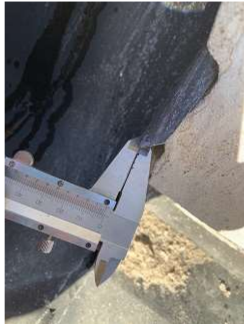
Fot. 38 Widok pomiaru grubości blachy..
