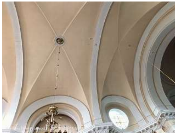
Fot. 48 Widok ogólny sklepień na pierwszym planie sklepienia klasztorne otwarte wsparte na ścianach i żebrach poprzecznych.
