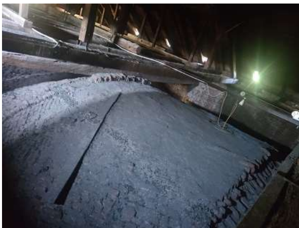
Fot. 49 Widok sklepienia klasztorne od góry w nawie głównej kościoła.
