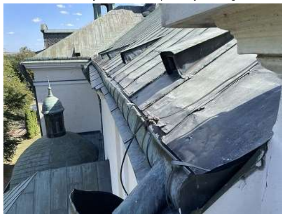
Fot. 62 Widok dachu z detalem rynny i obróbek.
