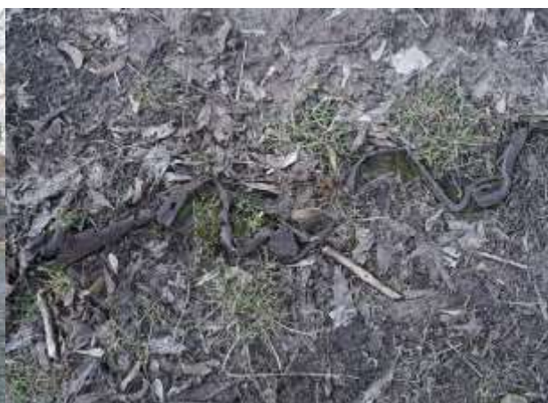
Fot. 15 Zdjęcie przedstawiająca ścianki stalowe typu larsena pozostawione w gruncie ze śladami ich zmiżdżenia po zabijaniu.
