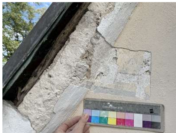
Fot. 64 Odkrywka bocznej obróbki.
