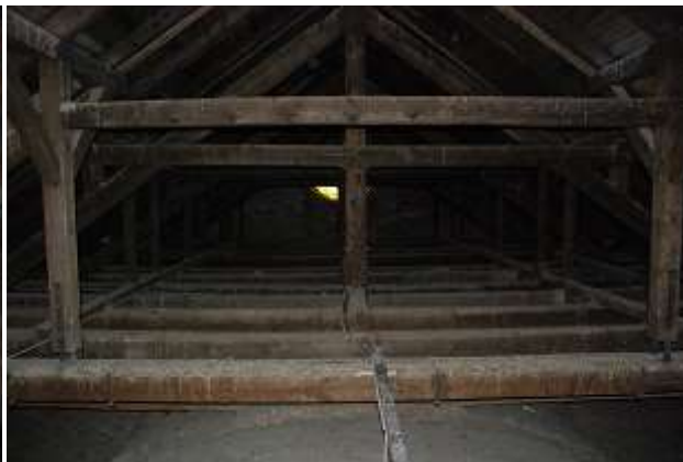
Fot.56 Zdjęcie więźby nawy głównej – dźwigar wieszarowy.
