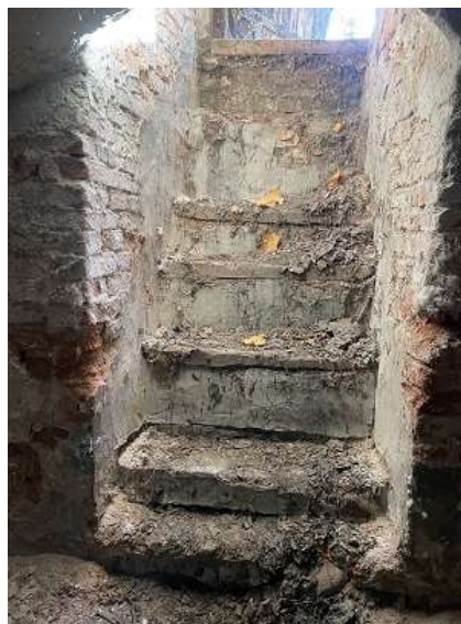
Fot. 17 Zdjęcie wejścia do krypty ze schodami w miejscu wejścia.
