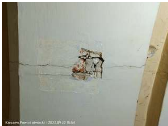
Fot. 53 Widok odkrywki sklepień na zębrze sklepienia kopułowego w nawie głównej.
