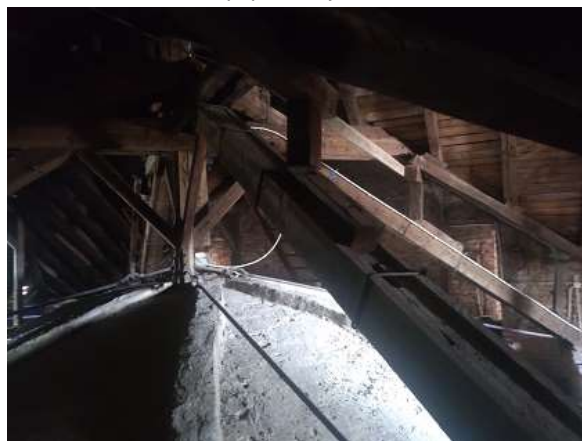
Fot. 48 Widok ogólny sklepień na pierwszym planie sklepienia klasztorne otwarte wsparte na ścianach i żebrach poprzecznych.
