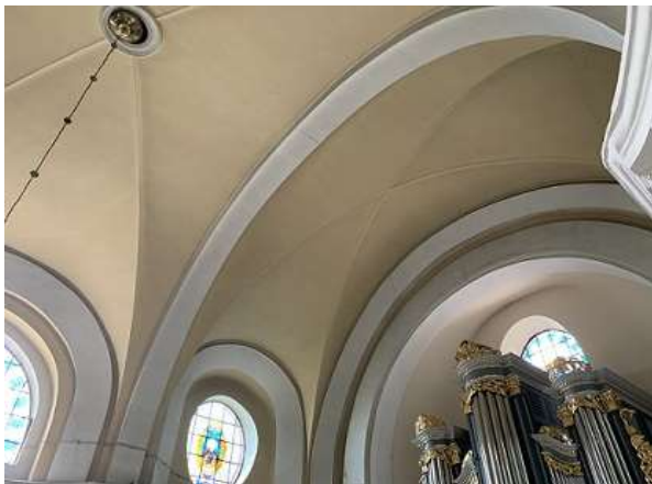
Fot. 47 Widok żebra poprzecznego wspierającego sklepienia klasztorne.
