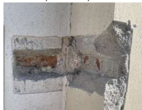
Fot. 40 Przykład uszkodzenia tynku, odkrywka nie wykazała zarysowania struktury muru.
