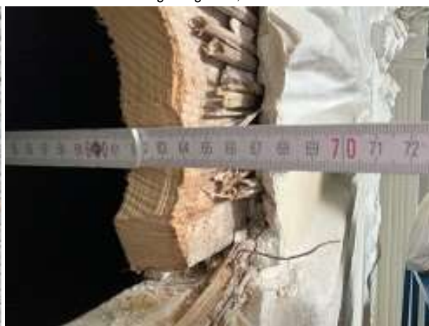
Fot. 22 Pomiar rozwartości rysy na nadprożu łuku ceglanego – 0,9mm.
