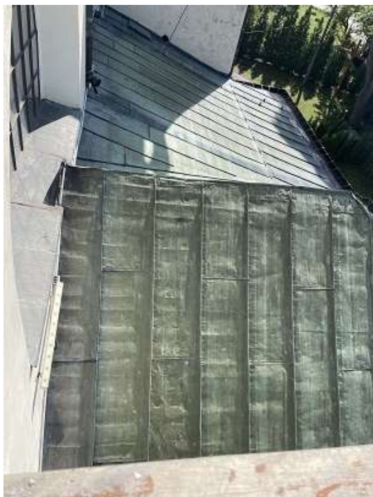
Fot.59 Widok dachu przybudówek bocznych.
