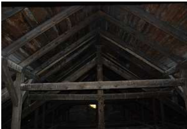
Fot. 55 Zdjęcie więźby nawy głównej.
