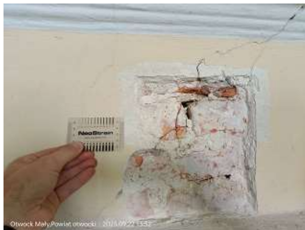
Fot. 22 Pomiar rozwartości rysy na nadprożu łuku ceglanego – 0,9mm.
