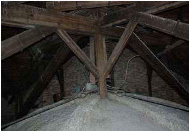
Fot. 57 Zdjęcie więźby nawy główne – dźwigar wieszarowy nad sklepieniem kopułowym.
