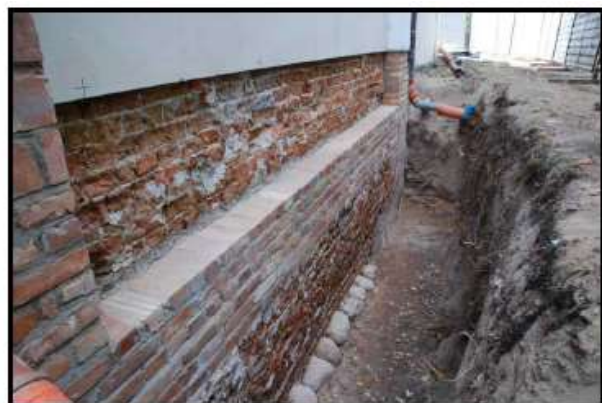
Fot. 8 Odkrywka fundamentów F4.
