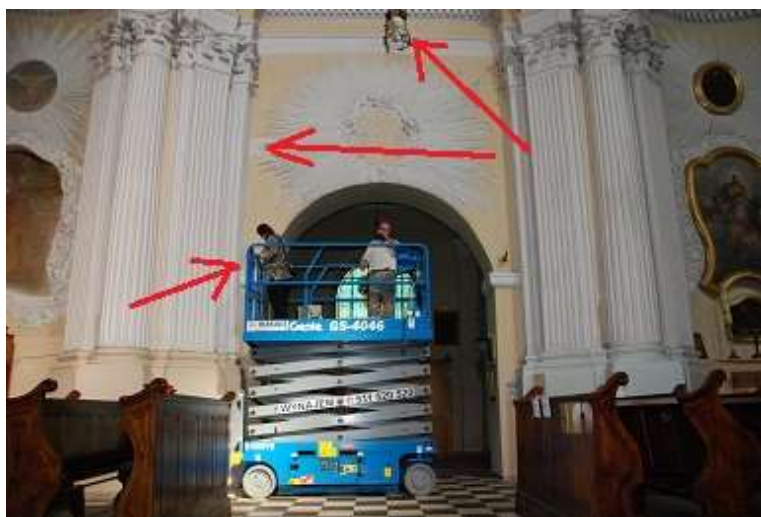
Fot. 20 Ściana boczna z miejscami odkrywek w miejscach zarysowań strukturalnych muru.
