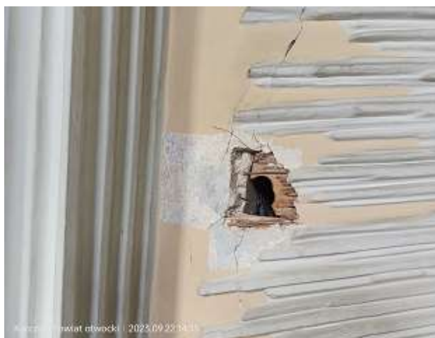
Fot. 23 Odkrywka muru w strefie bocznej sklepienia.
