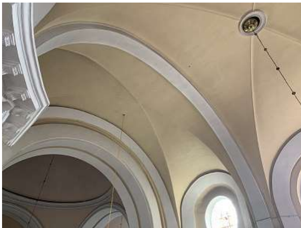
Fot. 45 Widok ogólny sklepień na pierwszym planie sklepienia klasztorne w głębi kopułowe.
