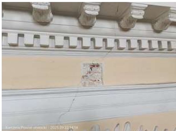
Fot. 21 Odkrywka muru nad sklepieniem.
