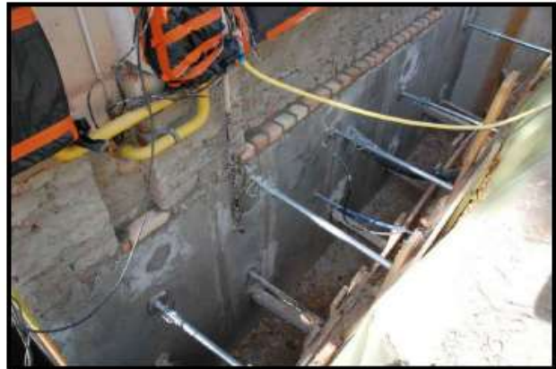
Fot. 11 Odkrywka fundamentów F7.
