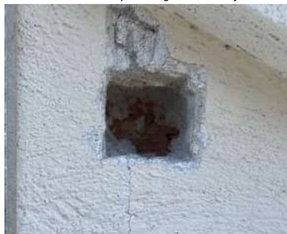
Fot. 40 Przykład uszkodzenia tynku, odkrywka nie wykazała zarysowania struktury muru.
