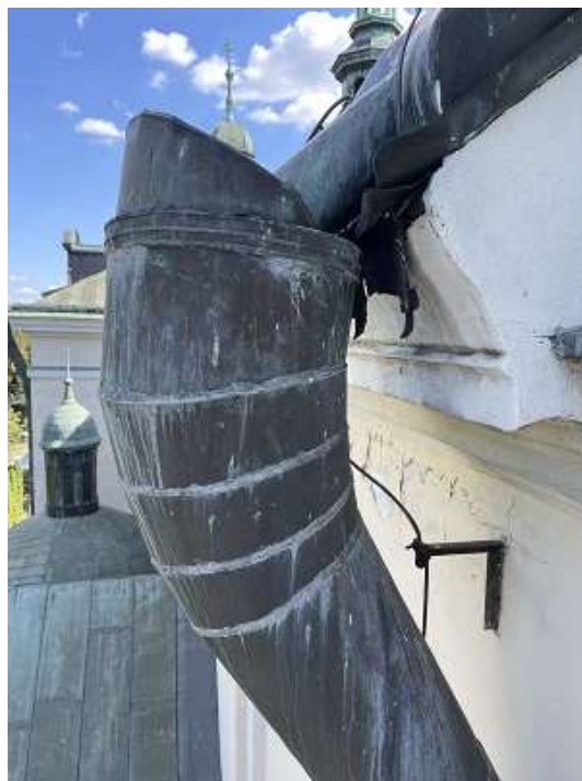
Fot. 60 Przykład detalu wpustu rynnowego.
