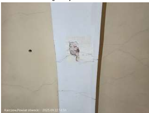
Fot. 51 Widok odkrywki sklepień na żebrze sklepień kolebkowych nawy głównej.
