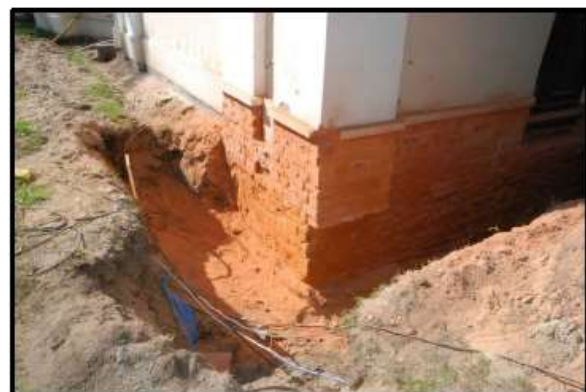
Fot. 10 Odkrywka fundamentów F6.
