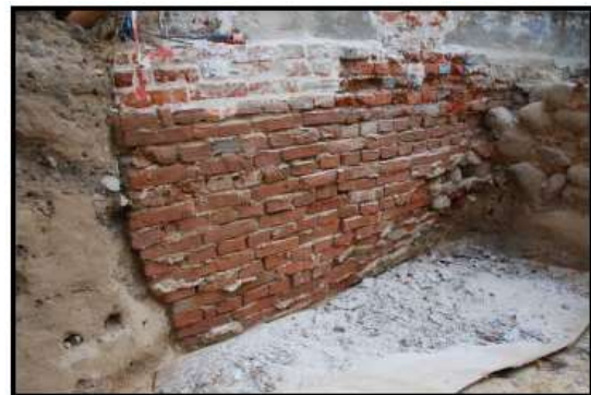
Fot. 7 Widok odkrywki F3.
