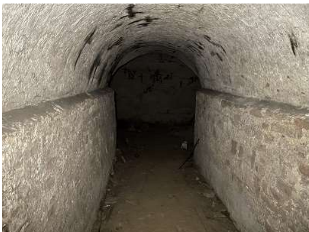
Fot. 18 Widok korytarza krypt.
