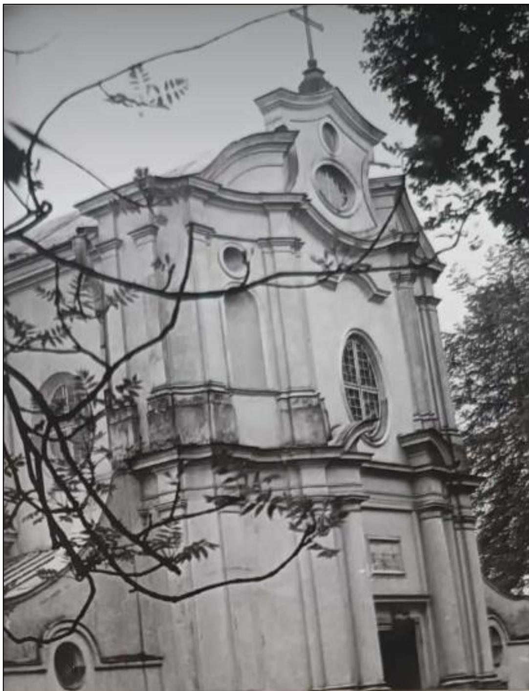
61. Fasada kościoła w Karczewie w 1975 r. Zdjęcie z opracowania L. Szindler "Rozpoznanie stanu technicznego zespołu kościoła parafialnego w Karczewie, pow. otwocki". Zbiory Archiwum Wojewódzkiego Urzędu Ochrony Zabytków w Warszawie, sygn. 310 A-C.
