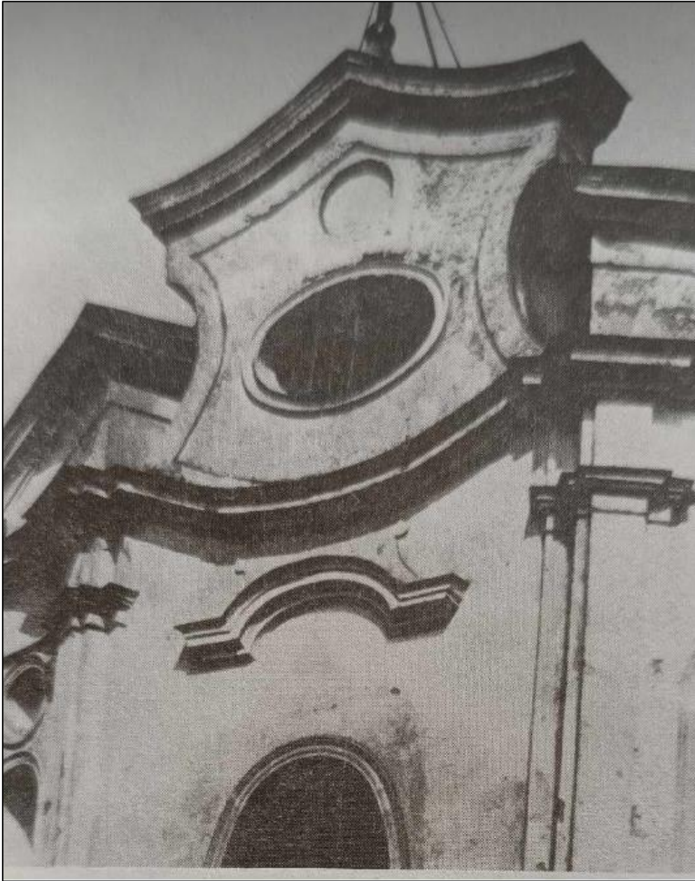
17. Fotografia z ok. 1913 r. przedstawiająca front kościoła. Źródło: K. Guttmejer, Kościół w Karczewie pod Warszawą - Kwartalnik Architektury i Urbanistyki, t. 37, 1992 r.
