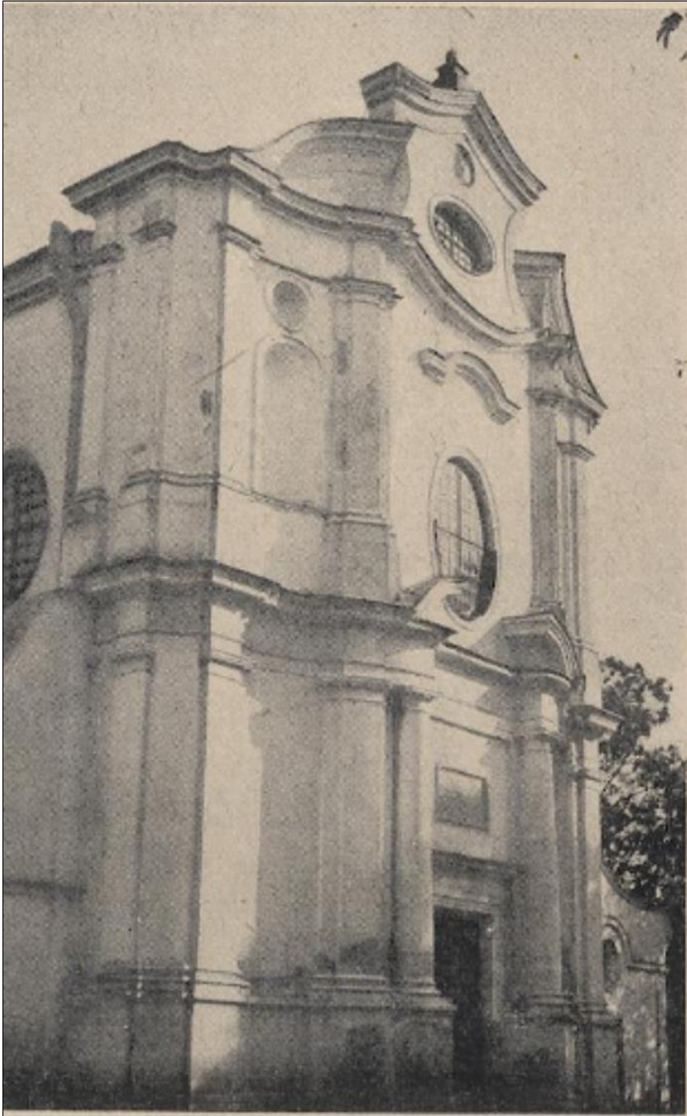
29. Fasada elewacji kościoła w Karczewie.
