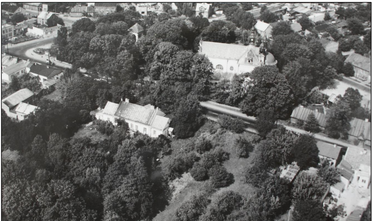
65. Zdjęcia z opracowania L. Szindler "Rozpoznanie stanu technicznego zespołu kościoła parafialnego w Karczewie, pow. otwocki". Zbiory Archiwum Wojewódzkiego Urzędu Ochrony Zabytków w Warszawie, sygn. 310 A-C.
