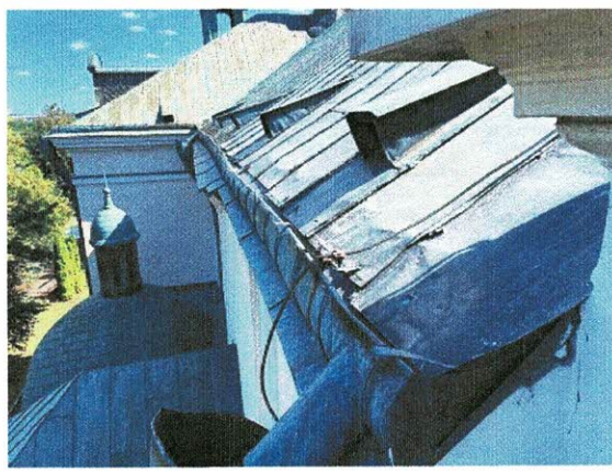
Fot. 6 Przykład detalu wpustu rynnowego.
