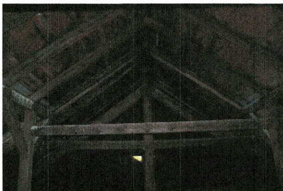
Fot. 1 Zdjęcie więźby nawy głównej.
