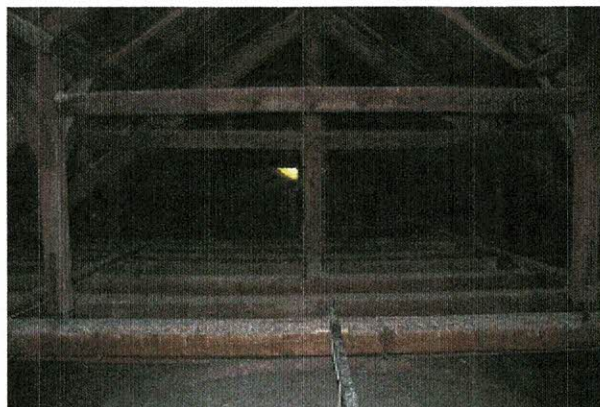
Fot. 2 Zdjęcie więźby nawy głównej – dźwigar wieszarowy.
