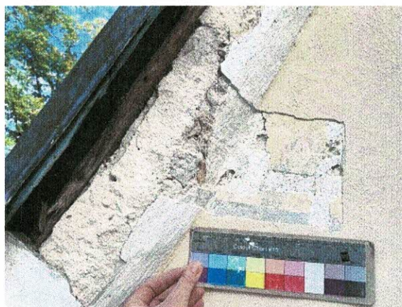
Fot. 10 Odkrywka bocznej obróbki.
